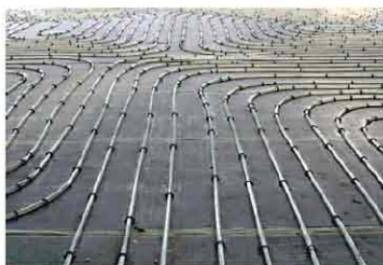
Es ideal para combinar con la energía solar térmica o bombas de calor geotérmicas, ya que la temperatura a la que circula el agua ronda los 40 °C, mientras que en los sistemas de radiadores convencionales es necesario elevarla hasta 60 °C o incluso más.
